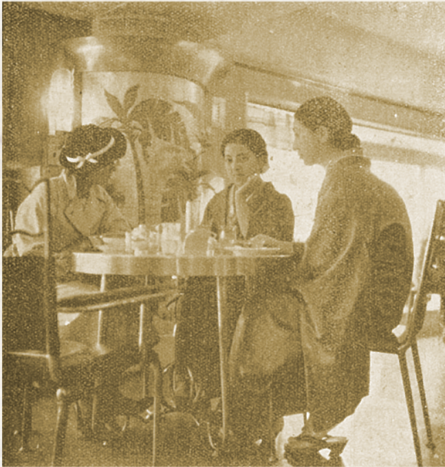
松坂屋上野店 本館 中2階のお洒落な喫茶室
